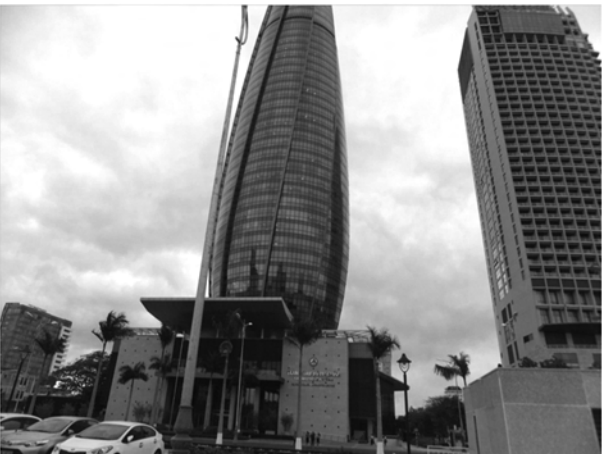
写真10 ダナン市総合庁舎（行政センター）
